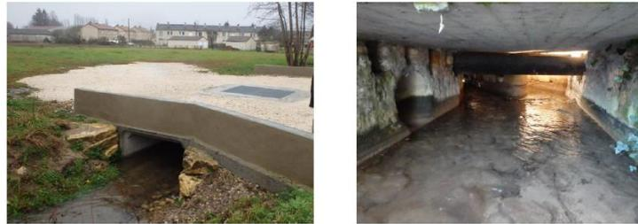
Figure 4 : aménagement d'un accès véhicule avec pont cadre placé sous le fil d'eau pour continuité hydraulique et écologique, pont historique avec agrandissement et obstacles inaccessibles, photo Infra Concept 2016
