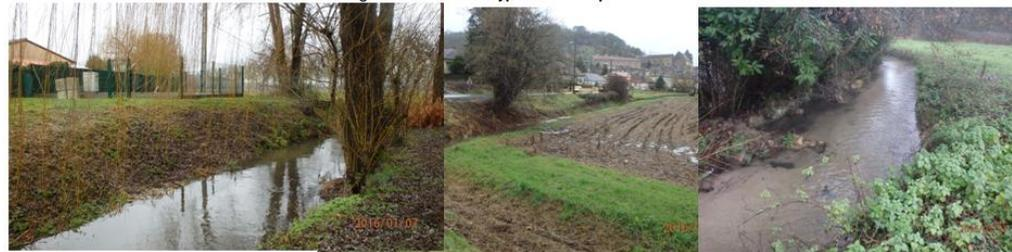
Figure 6 : aspect opposés de gestion des eaux naturelles, surcreusement de la largeur favorable à l'envasement et refermeture, atterrissement d'un bief et débordement, enrochement remblais et érosion provoquée juste en aval, photos InfraConcept, 2016
