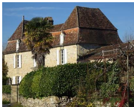
Le Garrit. 1835. Toiture à la Mansart.
