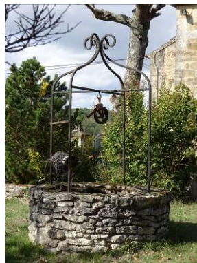
Fages, ferme. Puits à margelle circulaire en pierre.
