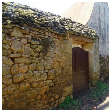
Bitou. Mur de clôture en moellons laissés apparents.
