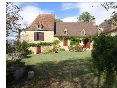
Fages. Rangs de lauzes conservés en toiture.
