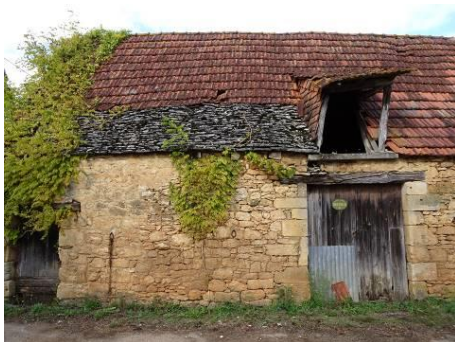
Le Meynet. Porte piétonne et porte charretière sous linteau bois d'une aranae-étable.
