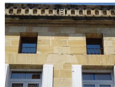
Avenue Gambetta. Façade en pierre de taille.
