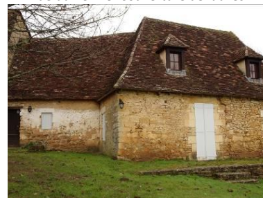
Couverture en tuile plate au Vézat.
