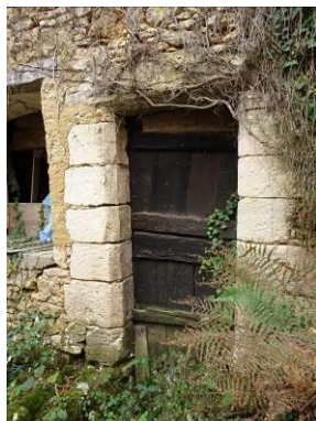
Le Faux. Pote à encadrement rectangulaire bordé d'un chanfrein reçu par des congés biais. 15 e – 16 e siècles ?
