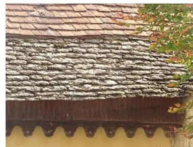
Rue du Terme. Couverture de lauzes.
