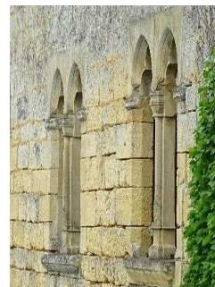
Repaire de Reignac. Fenêtre géminées, 14 e siècle.
