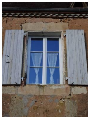
La Mativie. Fenêtre à encadrement rectangulaire avec feuillure. 19 e siècle
