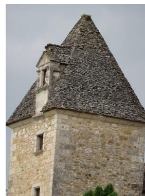
Cavaillès. Lucarnes en pierre avec bobines Renaissance (16 e siècle).
