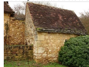
Couverture de lauzes partiellement conservée au Vézat.
