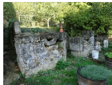
Les Caves. Soue à cochon ruinée
