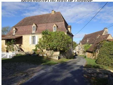
Péchalifour. A gauche, couverture à la Mansart, à droite, couverture en deux longs pans en tuiles plates.
