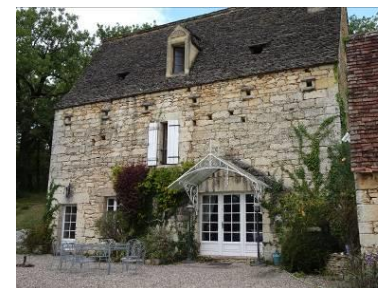
Lieu-dit Bagnerolles. Couverture de lauzes.
