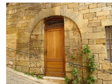
Rue du Terme. 19 e siècle.
