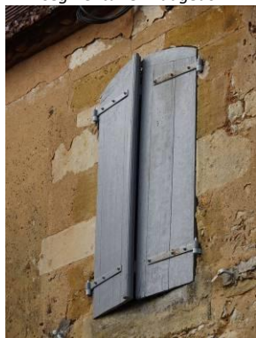
Flaugeac, ferme. Fenêtre à linteau en arc segmentaire avec feuillure. Fin 18 e siècle – 19 e siècle.
