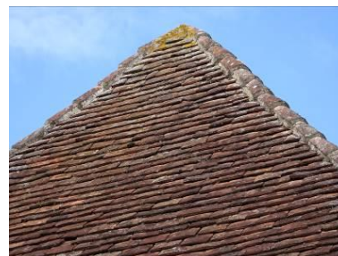
Flaugeac. Tuiles plates et arêtières en tuiles canal.
