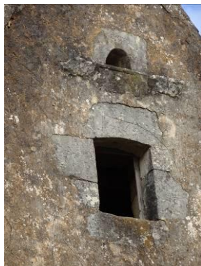
Fenêtre de grange du 18 e siècle à linteau en arc segmentaire. Flaugeac.
