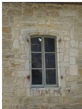
Rue Bertrand de Got. Fenêtre à meneau du 15 e siècle murée lors de l'installation d'une fenêtre au 18 e siècle.
