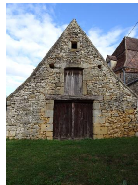
Grange du 18 e siècle à Péchalifour. Baie charretière à linteau de bois.
