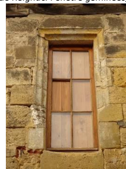
Impasse des Oies. Fenêtre à traverse.
