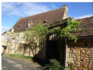
Péchalifour. Portail en arc en plein cintre couvert en lauzes calcaires. 18 e siècle ?
