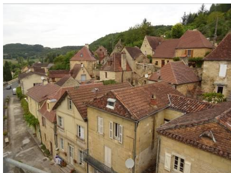
Vue de l'ancien barry de Becissut (appelé Montmartre) au nord de l'abbaye
