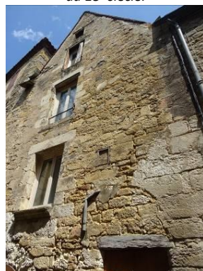
Rue de la Justice de Paix. Maison médiévales remaniée au 19 e siècle.
