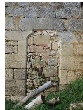
Lussac. Porte à linteau droit sur coussinets. 14 e siècle ?
