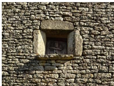
Capudie. Moellons calcaires. Pignon d'une dépendance agricole.
