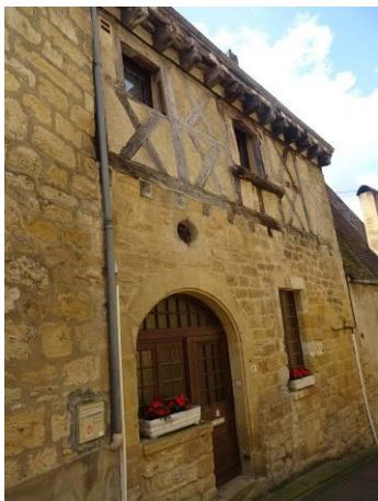
17, rue de la Justice de Paix. Pan de bois du 15 e siècle remanié au 18 e siècle.
