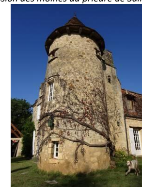
Pech de Laval. Repaire du 17 e siècle ?
