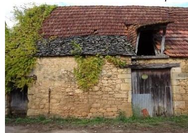
Le Meynet. Lauze et tuiles mécanique.
