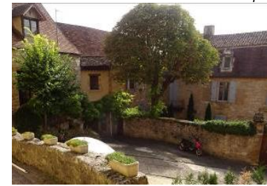
Place du Terme. Couverture de lauzes.
